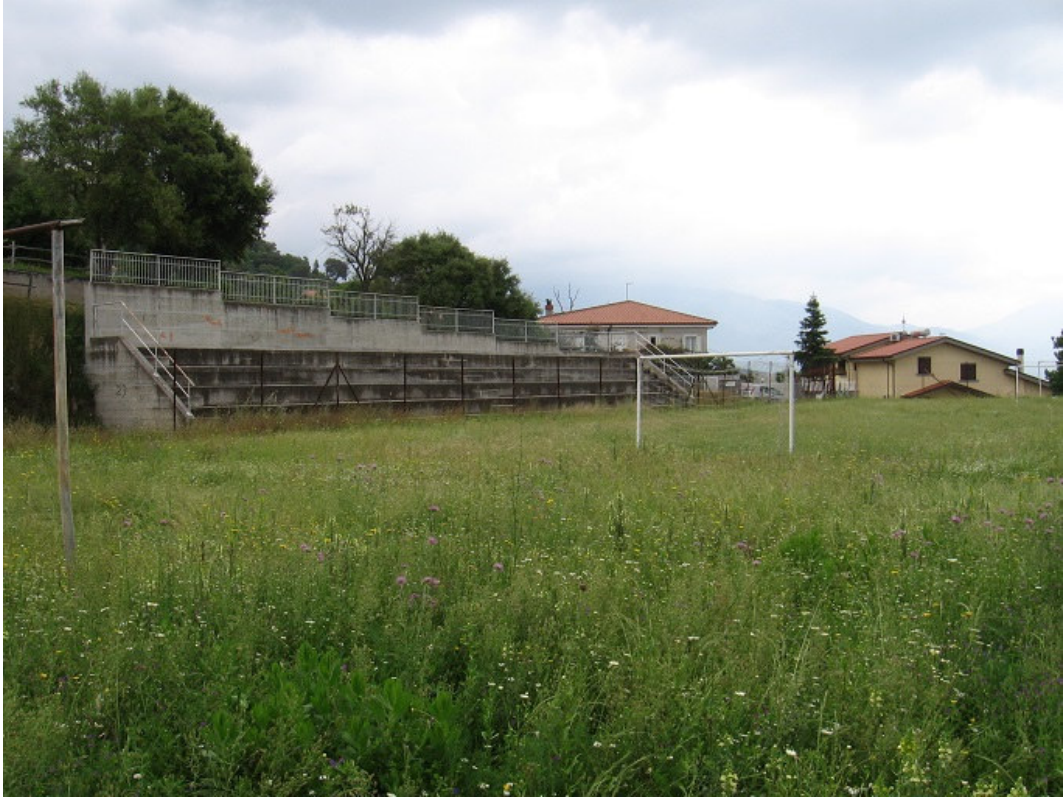
Foto n.2 Vista dal campo verso gli spalti
